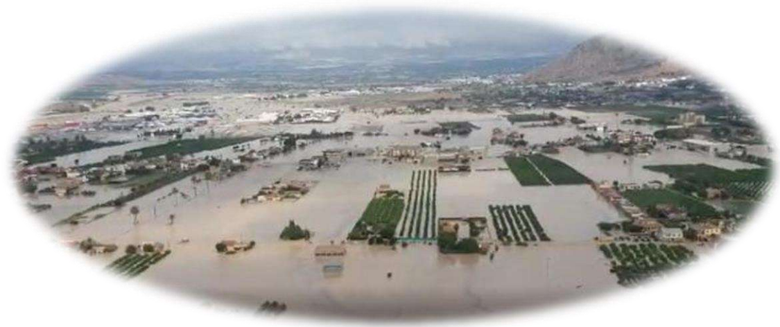
Figura 9.-Imagen de conjunto de la Vega Baja inundada
