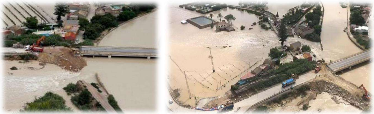
Figura 8.- Roturas de la mota del río Segura entre Almoradí y Algarfa.
