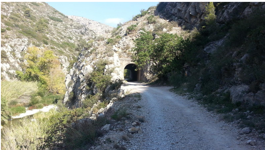
Túnel del tren Alcoi-Gandia.
