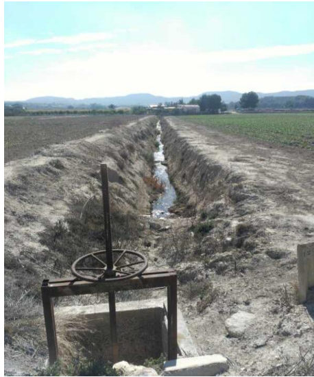
14. compuerta del mismo azarbe
