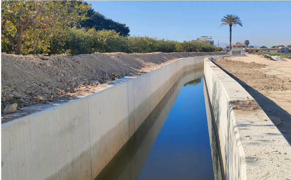
12. Acequia de la Alquibla tras las obras de reacondicionamiento en 2023
