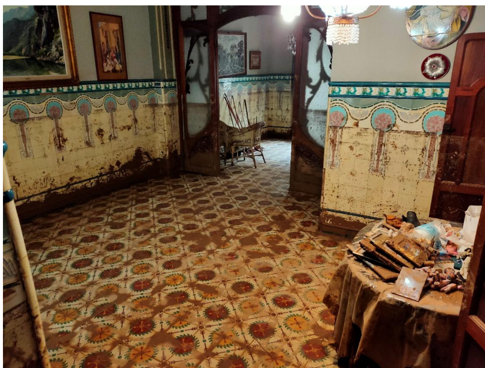
Interior d'una casa afectada per la DANA a Algemesí situada al carrer Muntanya datada a la primera meitat del segle XX
