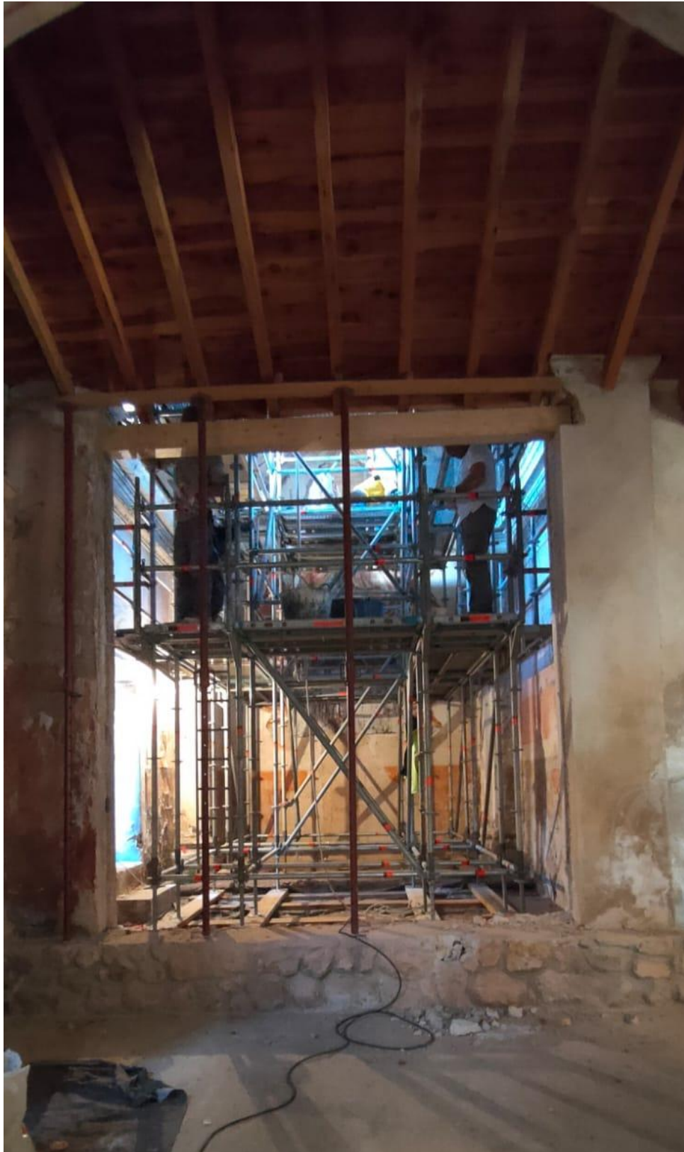
Fig. 3.1.4_ Vista tras la eliminación del tabique separador desde el interior de la nave de la iglesia.
