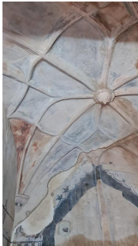
Fig.21 -23. Detalles de la recuperación del estrato original del S.XVI.
