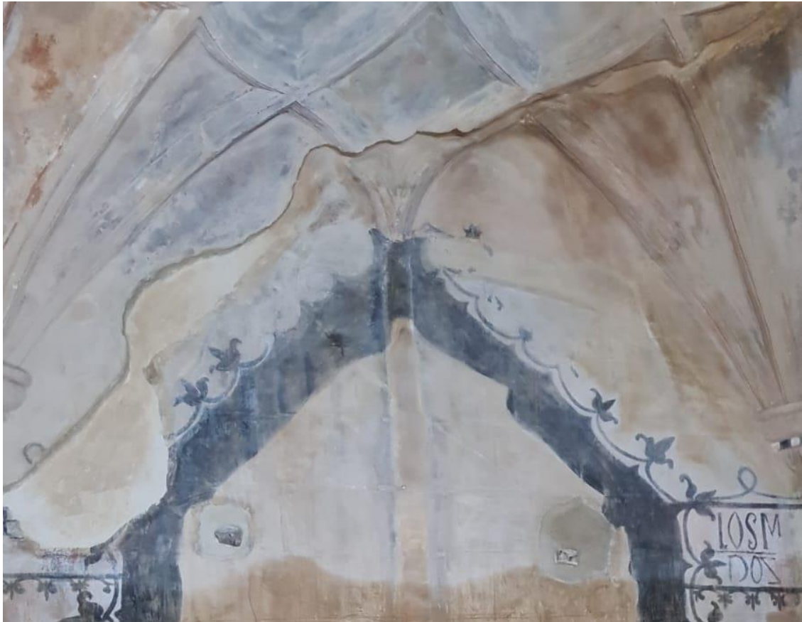
Fig.13 y 14. Relleno de gran pérdida del paramento con un importante desplazamiento por rotura.
