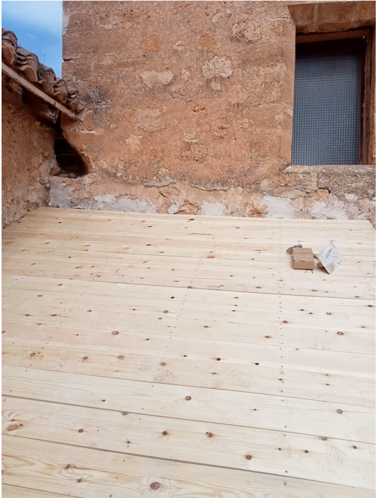
Fig. 3.2.5_ Colocación de tablero de madera sobre viguetas de madera.
