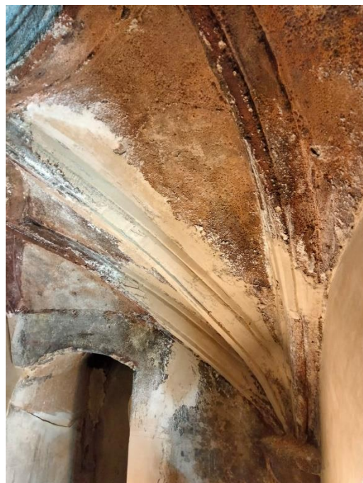
Fig.18 -20. Reposición-reconstrucción de elementos de yeso realizadas con yeso teñido en masa con pigmentos inorgánicos y tallados in situ.
