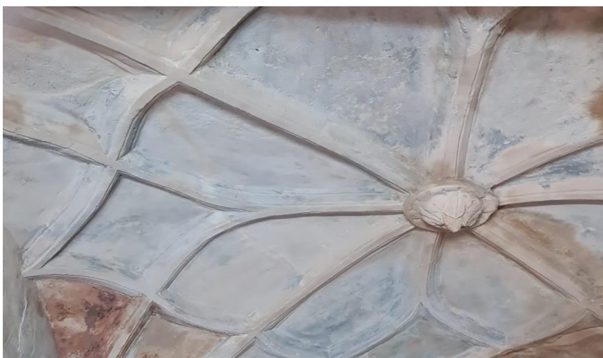
Fig.18 -20. Reposición-reconstrucción de elementos de yeso realizadas con yeso teñido en masa con pigmentos inorgánicos y tallados in situ.
