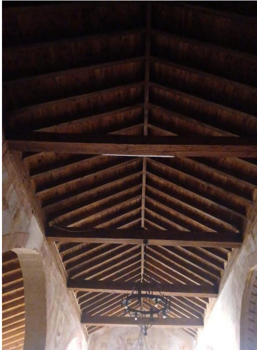
Armatures de la coberta del cos originari i del cor
