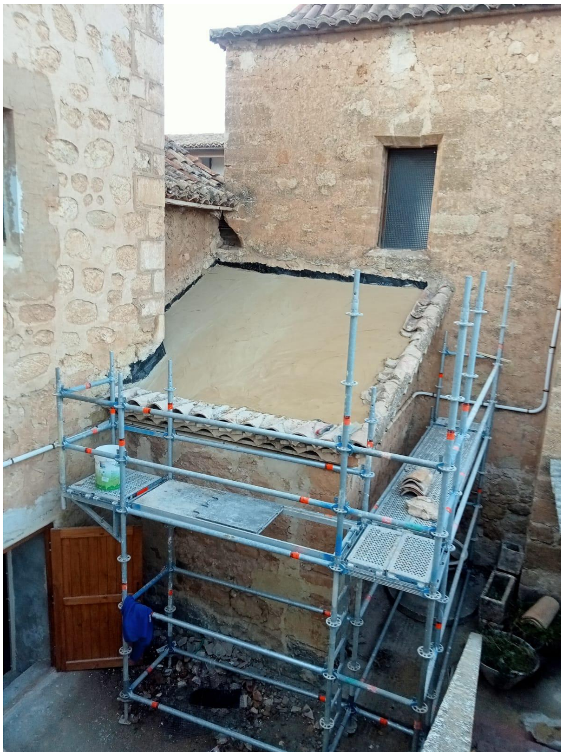
Fig. 3.2.7_ Colocación de lámina de regularización con mortero de cal Geocalce F y malla GeoGrid 120.
