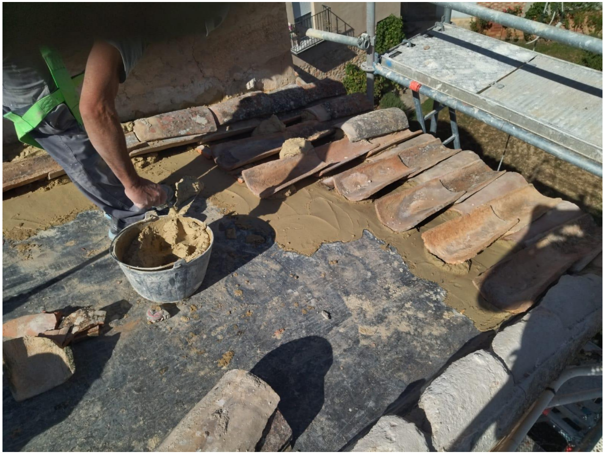
Fig. 3.3.12_ Colocación de lámina impermeable y teja recuperada.
