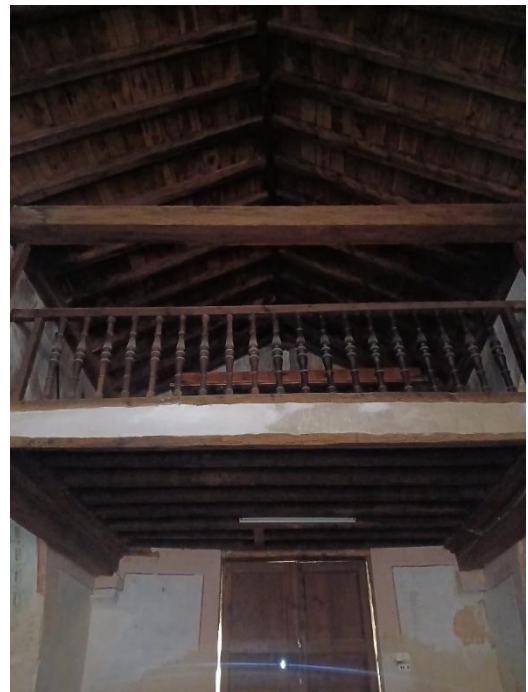
Armatures de la coberta del cos originari i del cor
