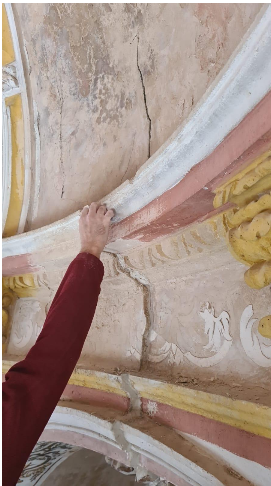
Fig. 3.3.18_ Relleno de grietas en el tambor de la cúpula del presbiterio.
