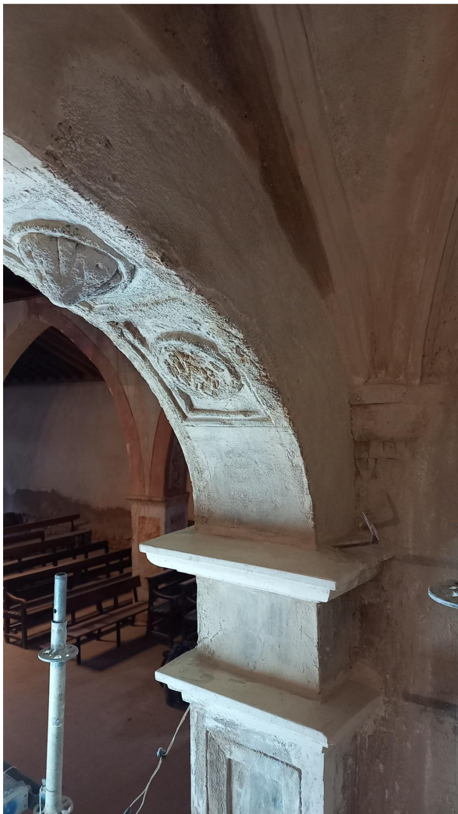
Fig. 3.2.9 Interior de la capilla. Detalle del arco.
