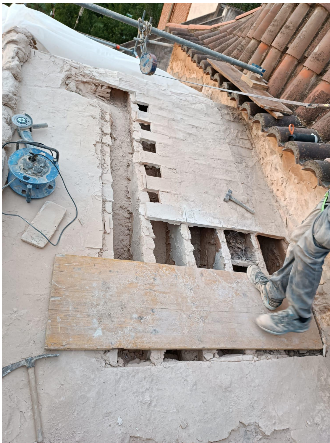
Fig. 3.3.8 Cubierta de la cabecera del presbiterio una vez retiras las tejas. Se observa que el tablero está compuesto por piezas cerámicas sobre tabiquillos cerámicos.
