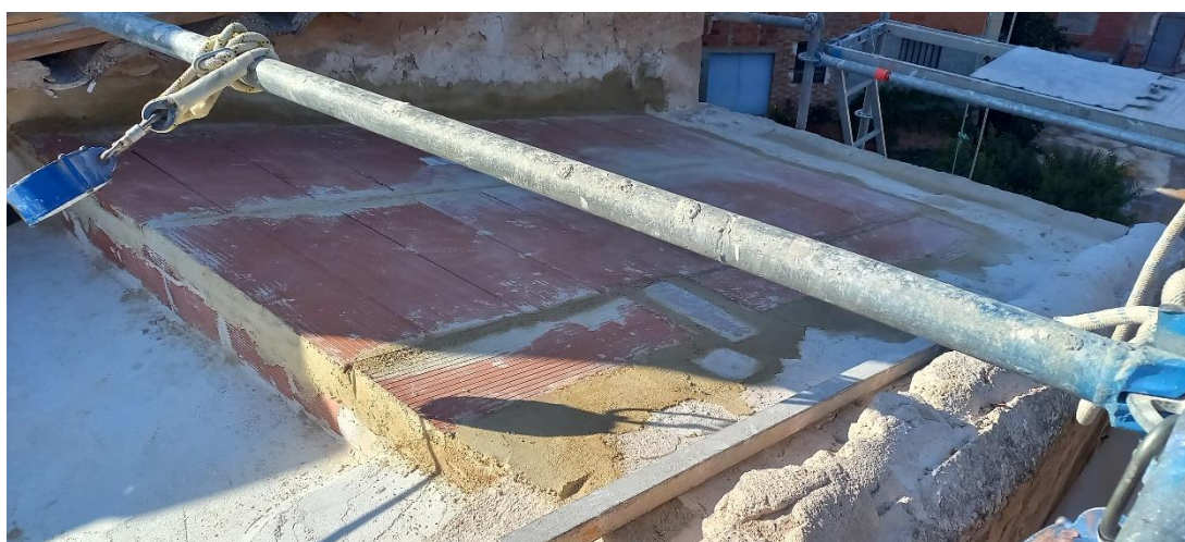
Fig. 3.3.11_ Colocación de tablero cerámico sobre tabiquillos.
