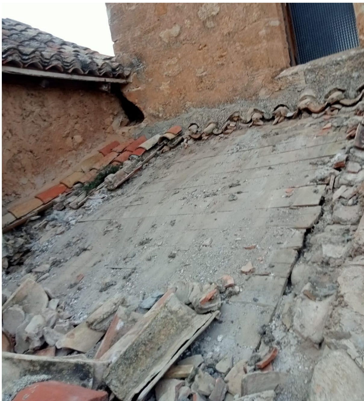
Fig. 3.2.3_ Retirada de tejado y entablamento de la cubierta de la capilla Detalle de la disposición del tablero de madera original.
