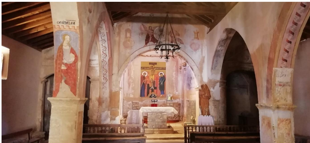
Fig. 3.3.1_ Vista del presbiterio desde el acceso previa la intervención.
