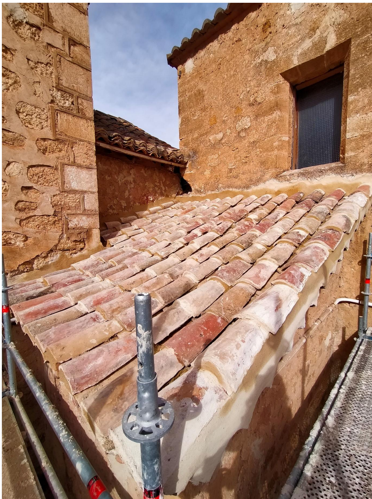
Fig. 3.2.8_Colocación de teja recuperada.
