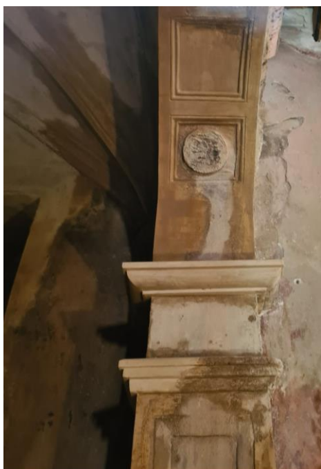
Fig.18 -20. Reposición-reconstrucción de elementos de yeso realizadas con yeso teñido en masa con pigmentos inorgánicos y tallados in situ.
