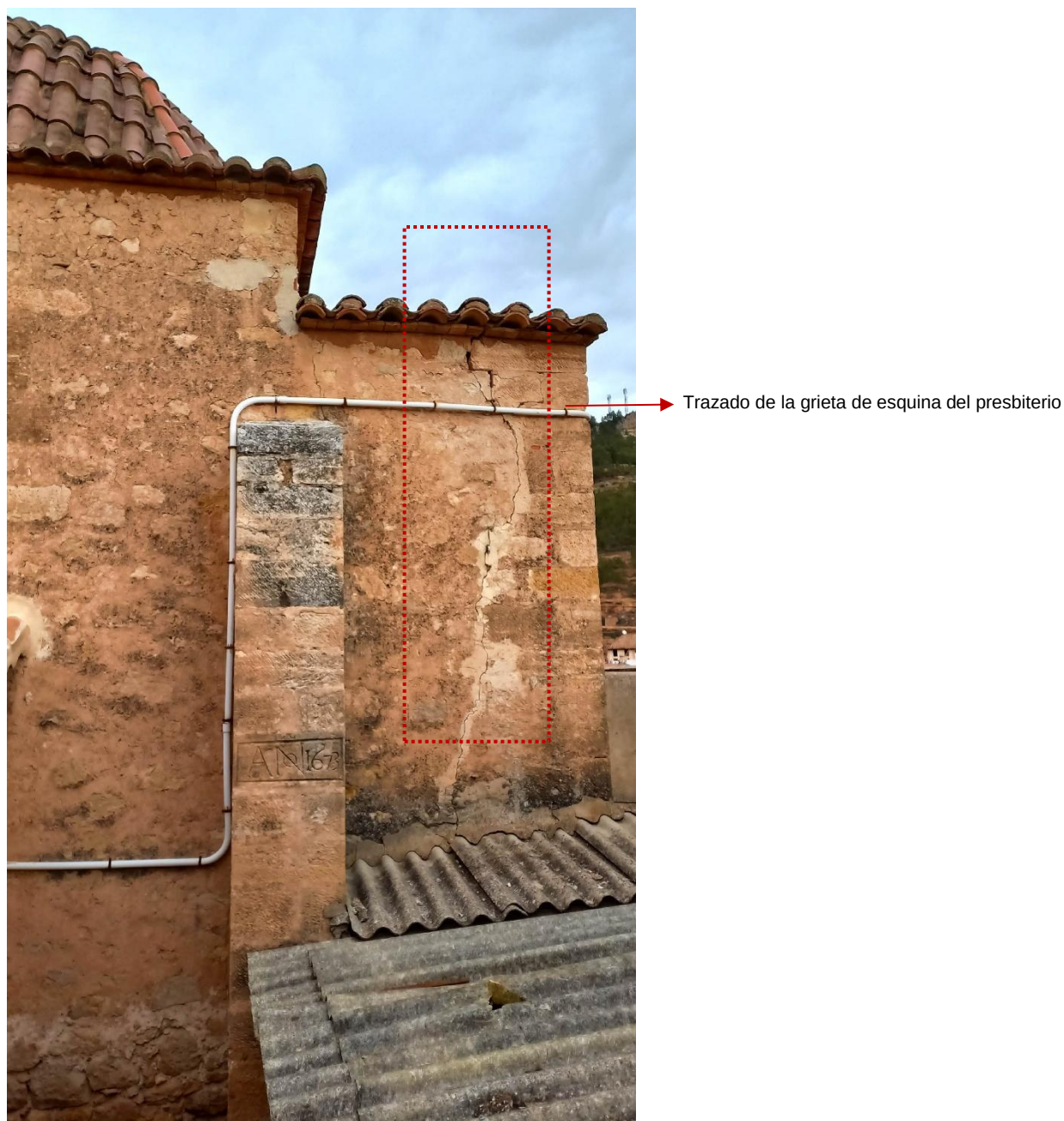
Fig. 3.3.3_ Vista exterior sur del presbiterio previa a la intervención.
