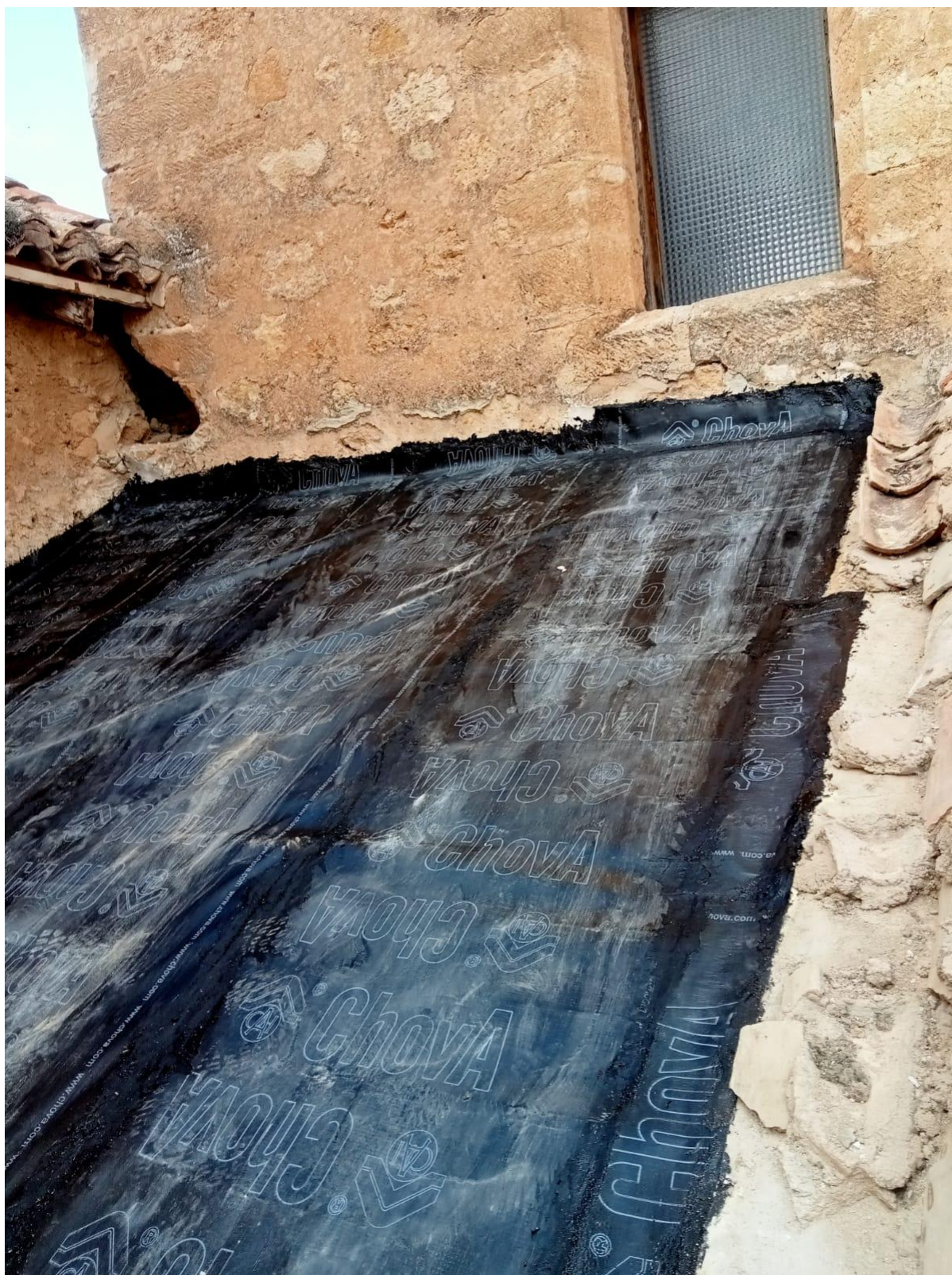
Fig. 3.2.6_Colocación de lámina impermeable.
