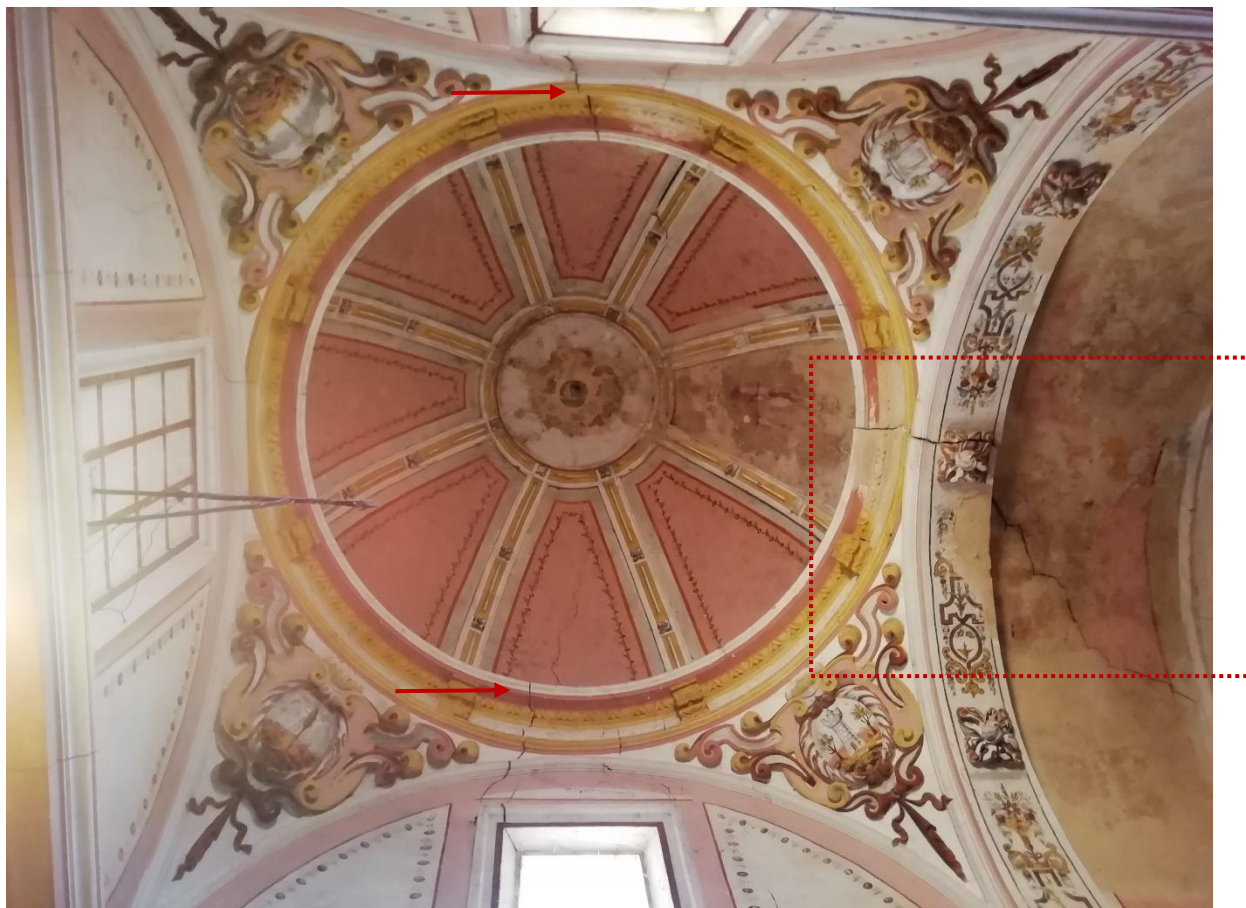
Fig. 3.3.2_ Vista cenital de la bóveda del presbiterio previa a la intervención.
