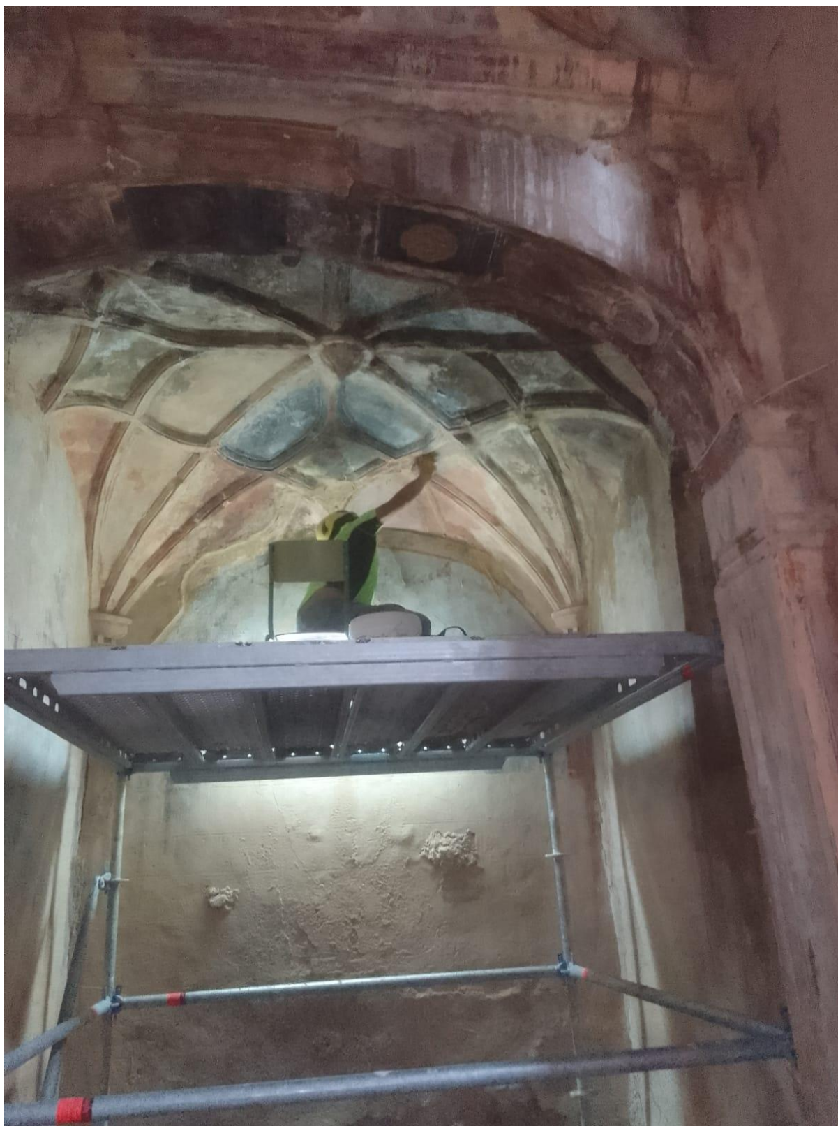
Fig. 3.2.2_Preparación del interior de la capilla previa actuación en el exterior de la misma.
