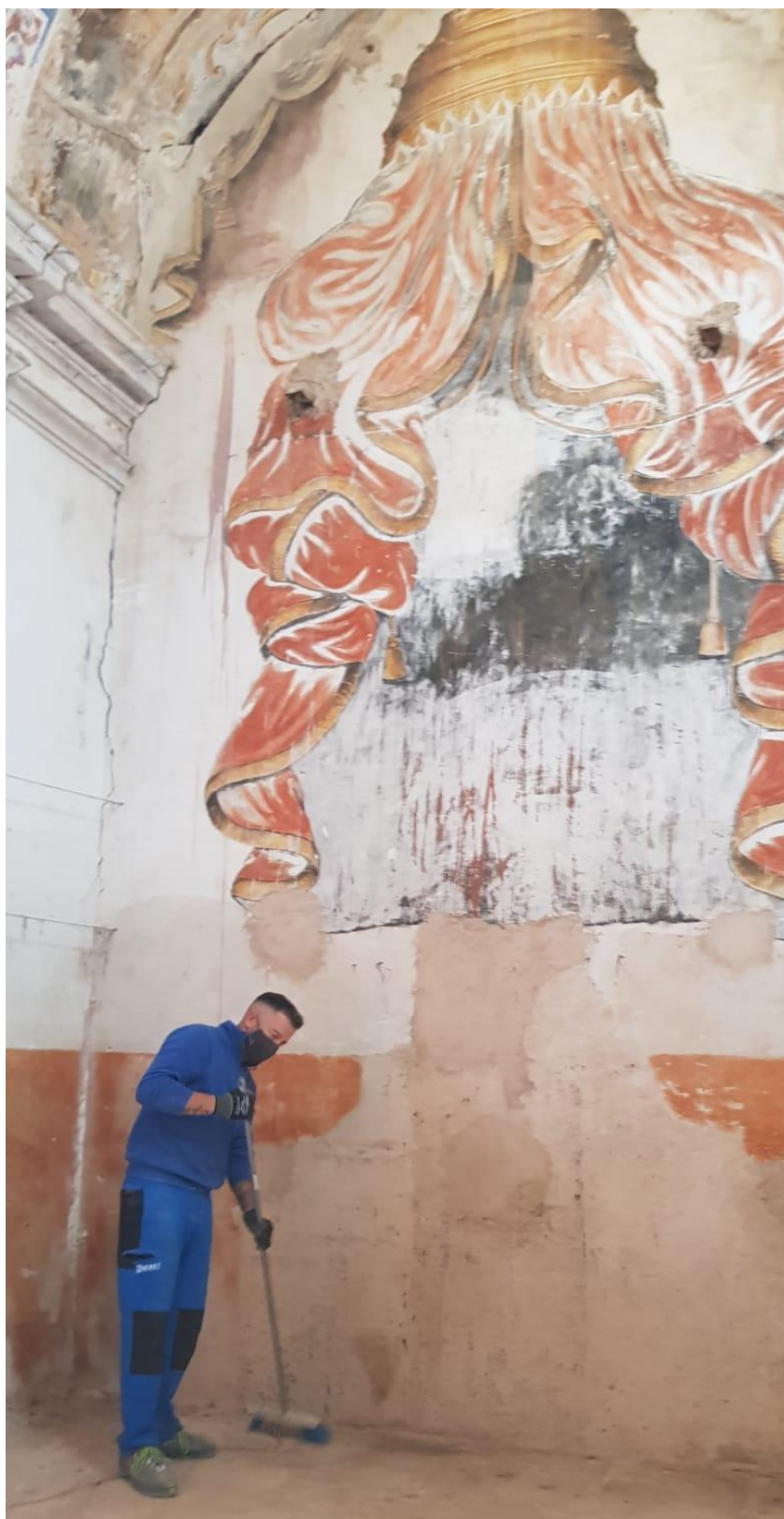
Fig. 3.1.2_ Estado previo de la capilla.
