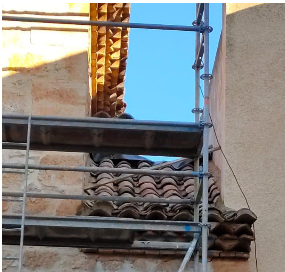
Fig. 3.1.14_ Retejado de la cubierta.
