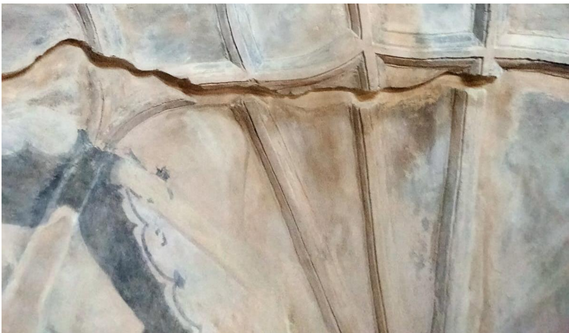
Fig.13 y 14. Relleno de gran pérdida del paramento con un importante desplazamiento por rotura.
