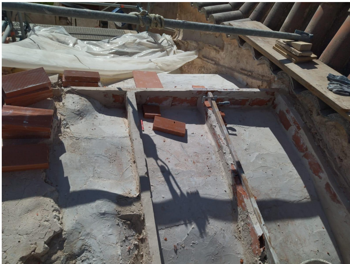
Fig. 3.3.10_ Refuerzo de la bóveda mediante malla GeoSteel_G600 y Geocalce F y posterior colocación de tabiquillos cerámicos.
