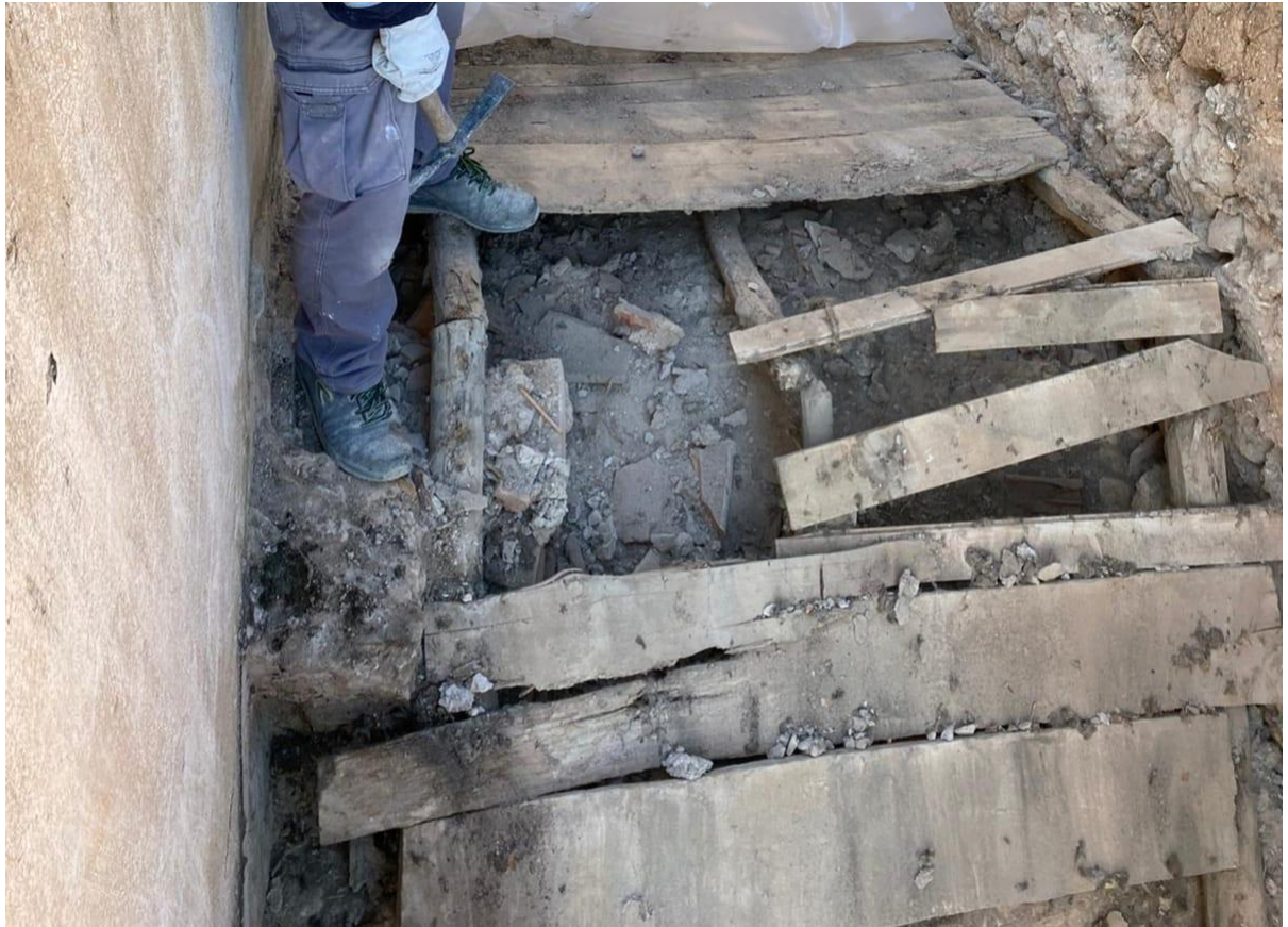
Fig. 3.1.9_ Estado previo de la cubierta. Retirada de tejado y entablamento de cubierta del ábside de la capilla.
