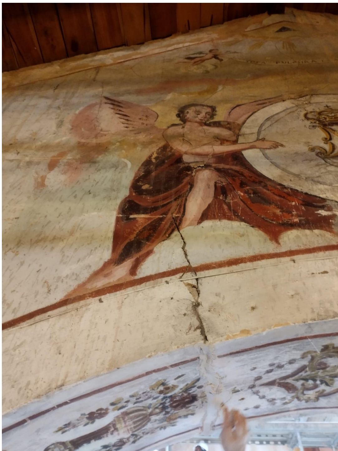
Fig. 3.3.17_ Relleno de grietas en intradós de arco toral de la cúpula del presbiterio.
