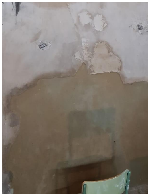
Fig.15 – 17. Reposición de faltantes con la aplicación de morteros de cal (en proceso de secado)
