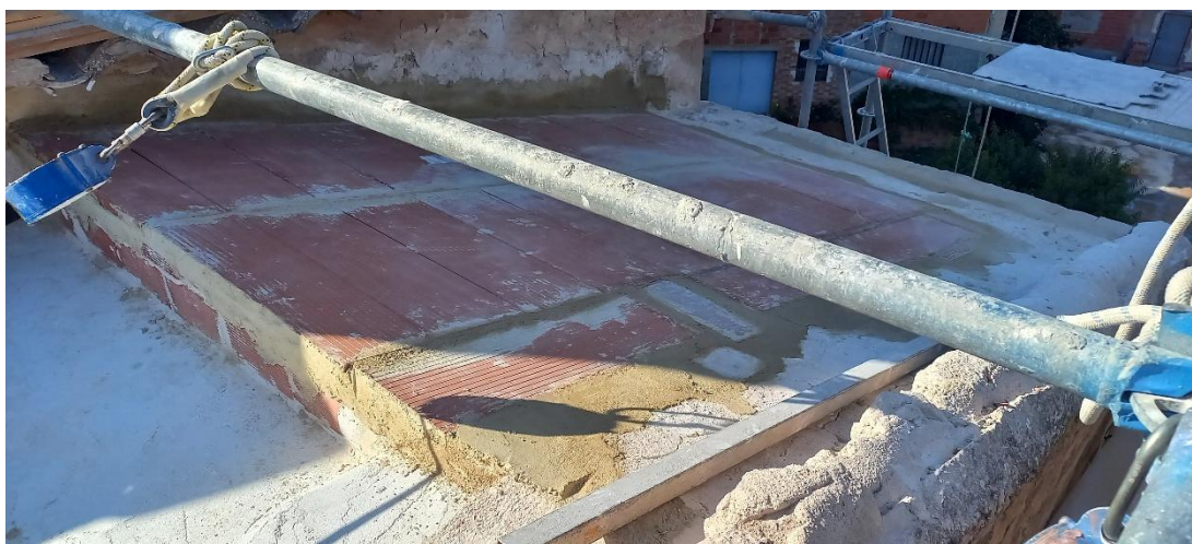
Fig. 3.3.11_ Colocación de tablero cerámico sobre tabiquillos.
