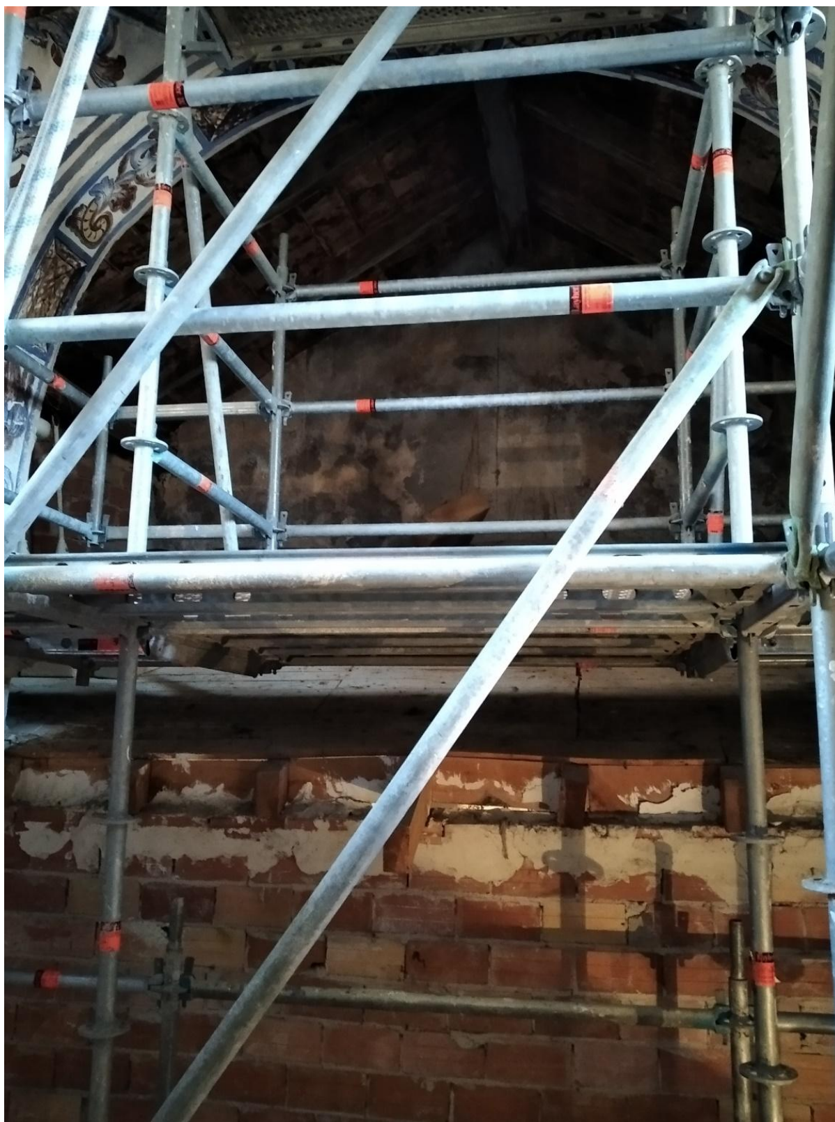
Fig. 3.1.3 _Vista inicial del tabique separador. Se aprecia el bajocubierta de la nave.
