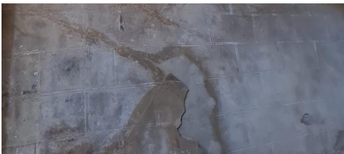
Fig.15 – 17. Reposición de faltantes con la aplicación de morteros de cal (en proceso de secado)
