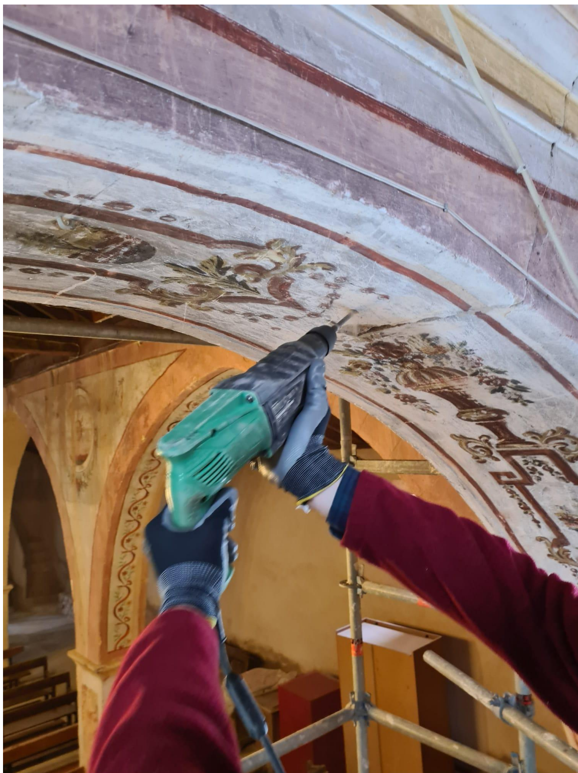
Fig. 3.3.15_Cosido de grietas mediante varillas de Ø4mm.
