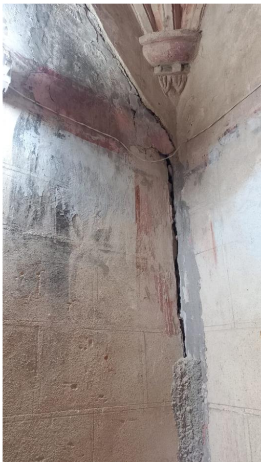
Fig.1 y 2. Detalle de fingido de sillares con junta incisa y de elementos ornamentales de yeso.
