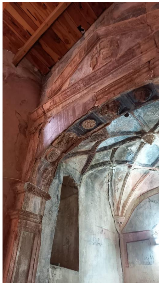
Fig.1 y 2. Detalle de fingido de sillares con junta incisa y de elementos ornamentales de yeso.
