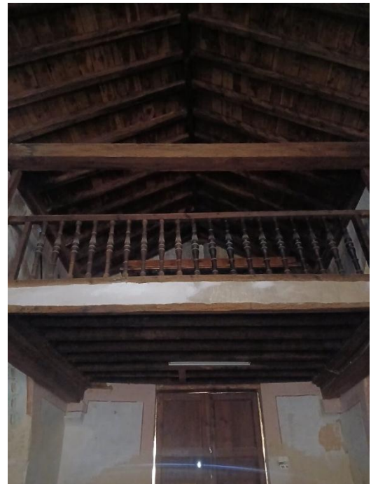
Armaduras de la cuberta del cos original i del cor
