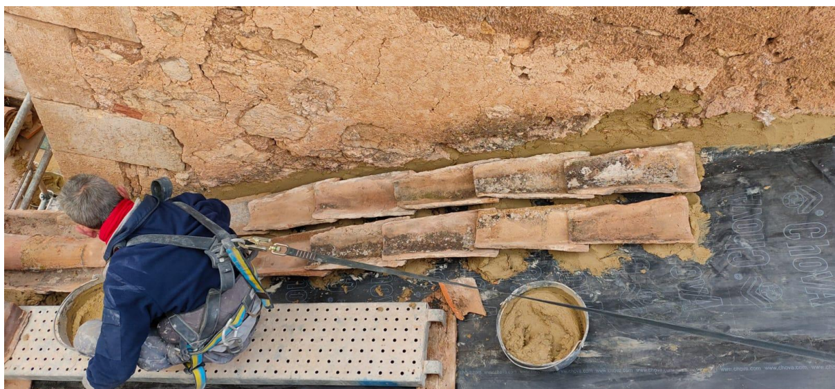
Fig. 3.1.13_ Colocación de lámina impermeable previa al retejado con las tejas recuperadas.
