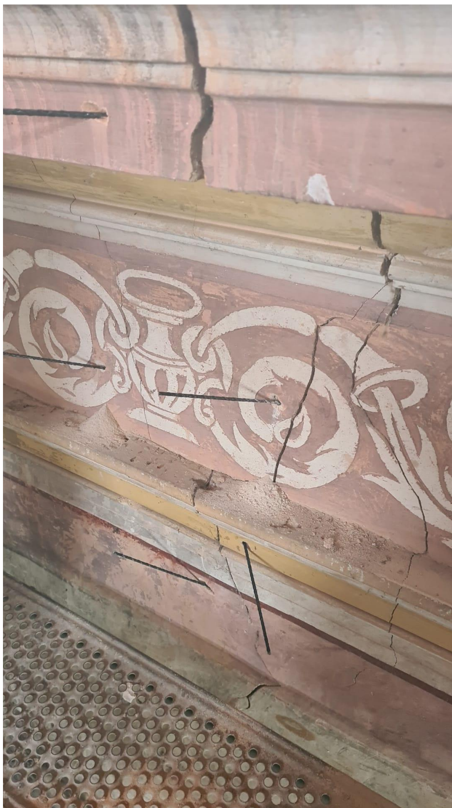
Fig. 3.3.16_Detalle de proceso de cosido mediante varillas.
