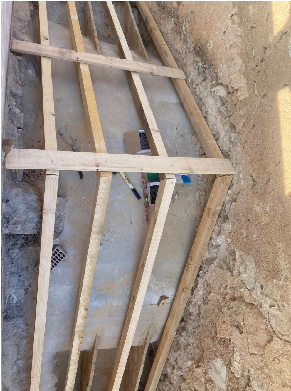
Fig. 3.1.11_ Colocación de nuevas viguetas y tablero de madera.
