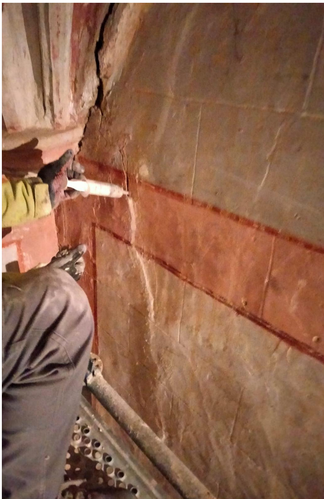
Fig. 3.3.19_ Inyección a base de yeso para consolidación de estrato pictórico en la capilla norte anexa al presbiterio.
