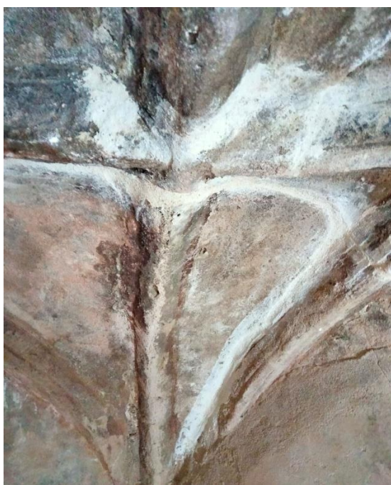
Fig.15 – 17. Reposición de faltantes con la aplicación de morteros de cal (en proceso de secado)
