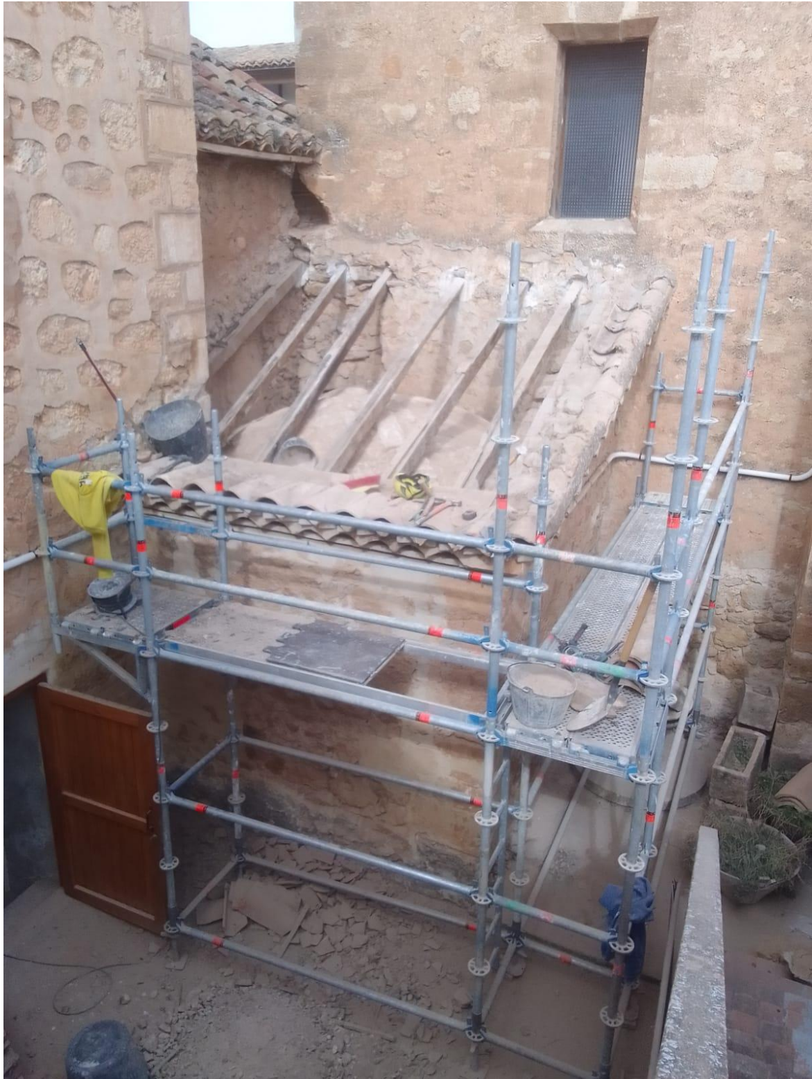
Fig. 3.2.4_Vista general del exterior de la capilla (se aprecia la bóveda interior de la misma).
