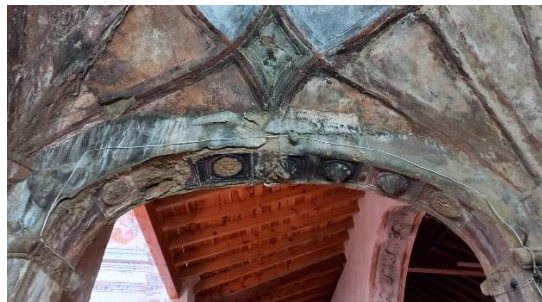
Fig. 3 y 4. Detalle del interior de la capilla donde a simple vista puede apreciarse todos los daños descritos. Fractura del paramento, escoriaciones, lixiviaciones, erosiones y disgregación de los yesos.
