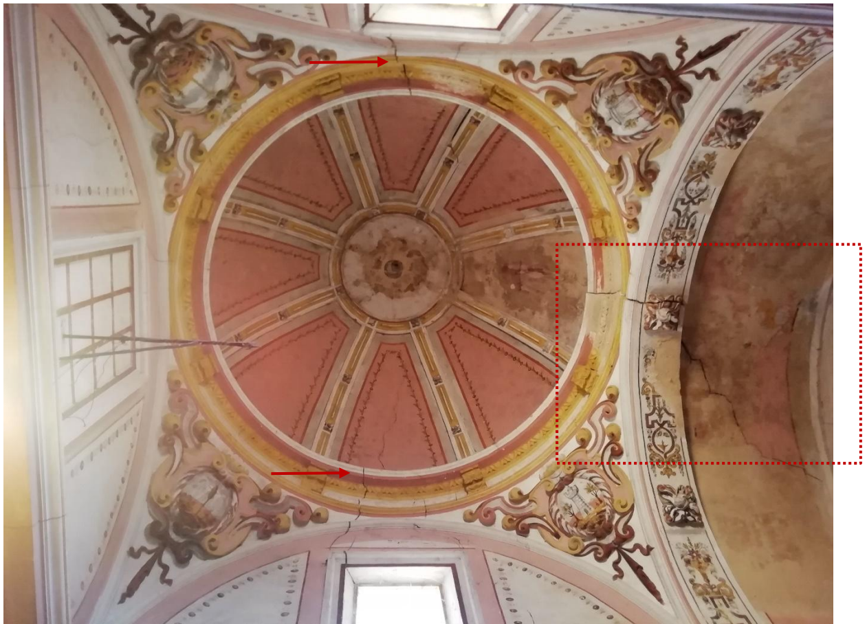
Fig. 3.3.2_ Vista cenital de la bóveda del presbiterio previa a la intervención.
