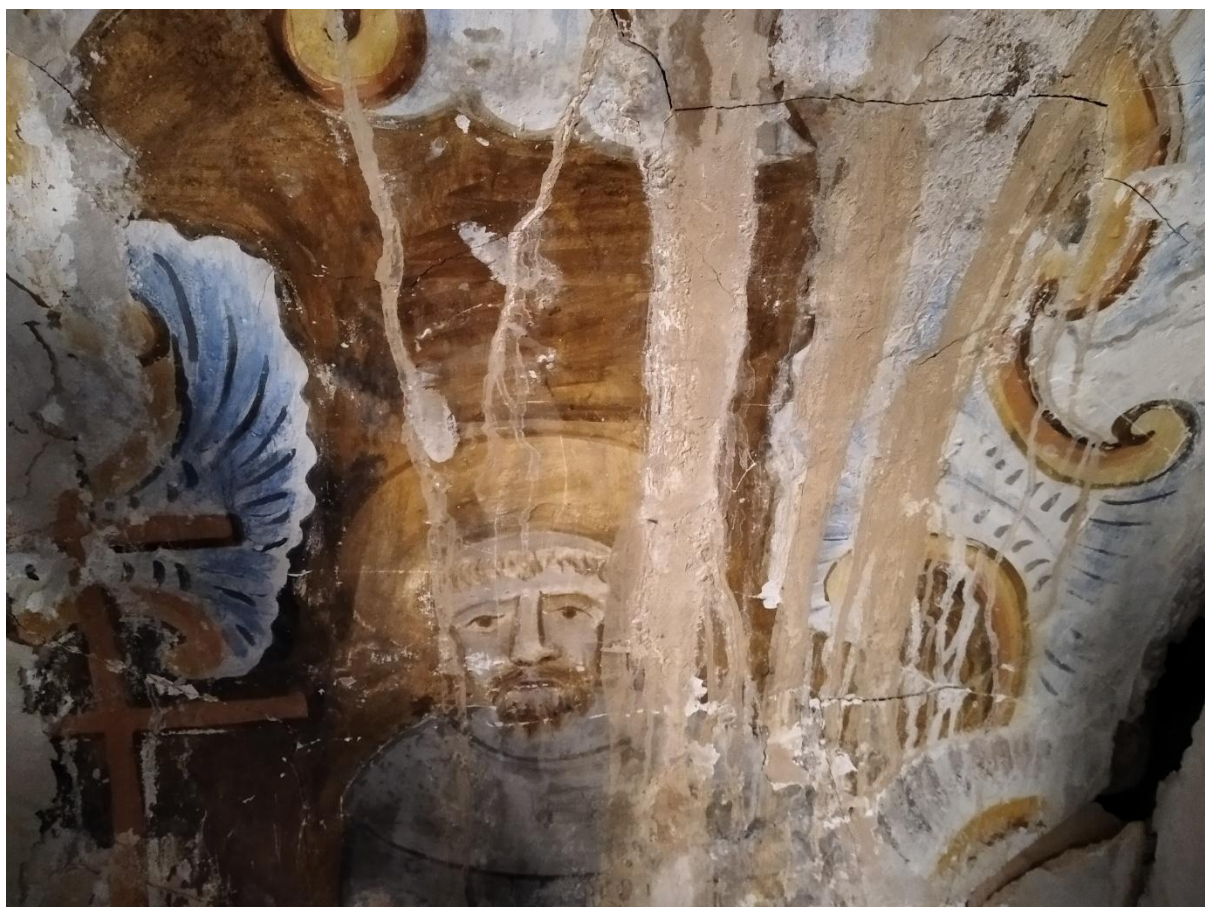
Fig. 3.1.5_ Imagen de las pinturas originales del s. XVIII situadas en la cabecera de la capilla (encuentro con edificio colindante). La importancia de dichas pinturas ha sido posible constatarlas una vez colocado el andamio para las labores de restauración.
