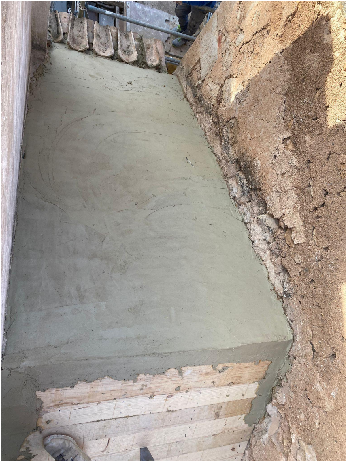
Fig. 3.1.12_ Colocación de capa de mortero de cal sobre nuevo tablero de madera.
