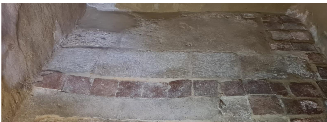
Fig.25. Detalle de los restos conservados del pavimento que compone la capilla.
