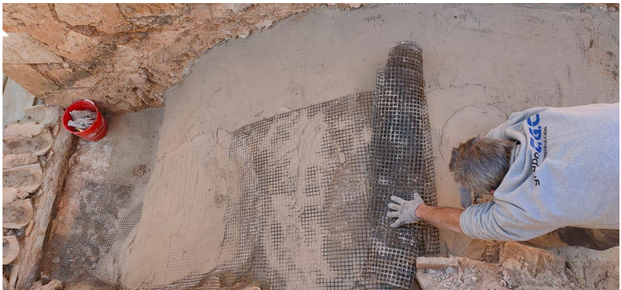
Fig. 3.1.10_ Refuerzo de la bóveda con malla y mortero de cal.
