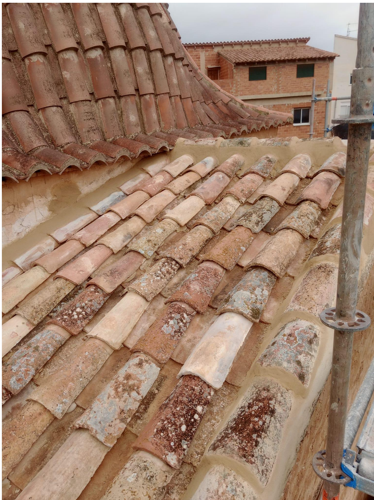
Fig. 3.3.12_ Vista general de la cubierta con la colocación de teja recuperada.
