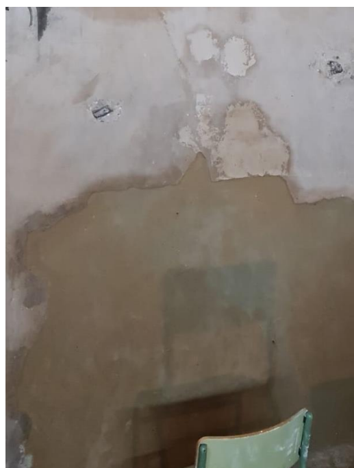
Fig.15 – 17. Reposición de faltantes con la aplicación de morteros de cal (en proceso de secado)
