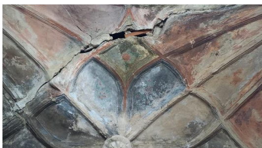
Fig. 3 y 4. Detalle del interior de la capilla donde a simple vista puede apreciarse todos los daños descritos. Fractura del paramento, escoriaciones, lixiviaciones, erosiones y disgregación de los yesos.
