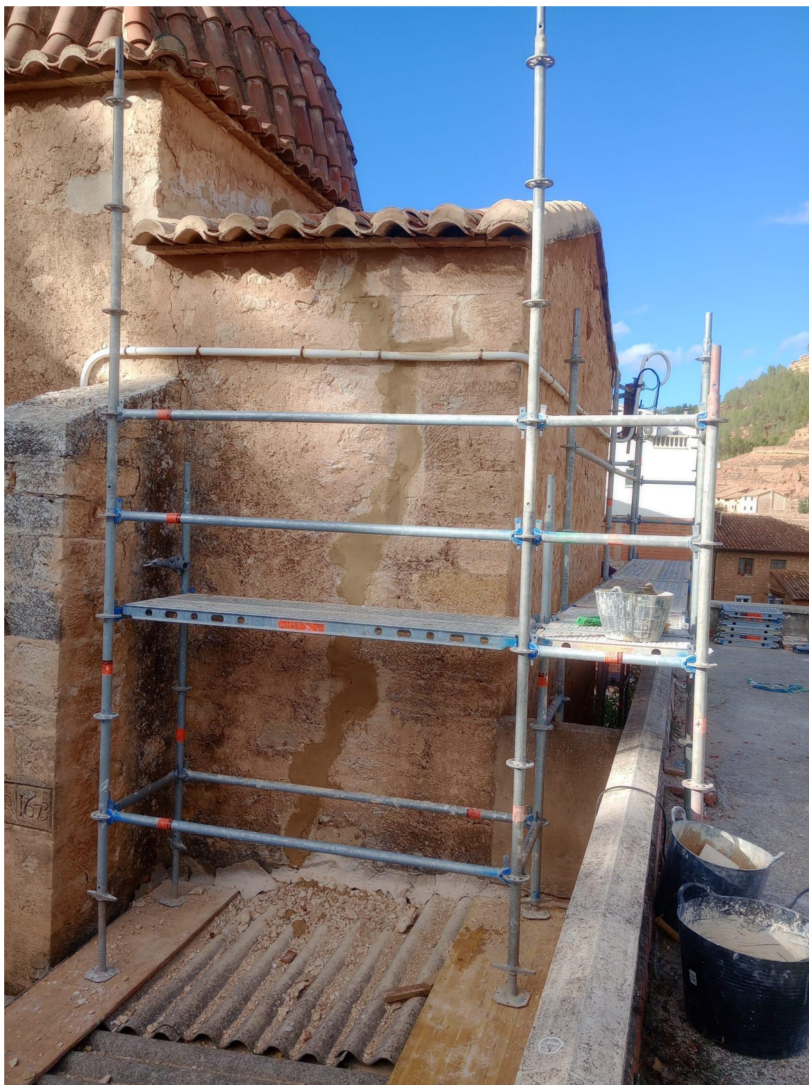
Fig. 3.3.14 _Aspecto general de la esquina del muro tras la intervención.
