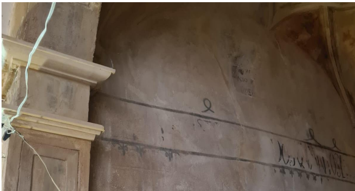
Fig.21 -23. Detalles de la recuperación del estrato original del S.XVI.
