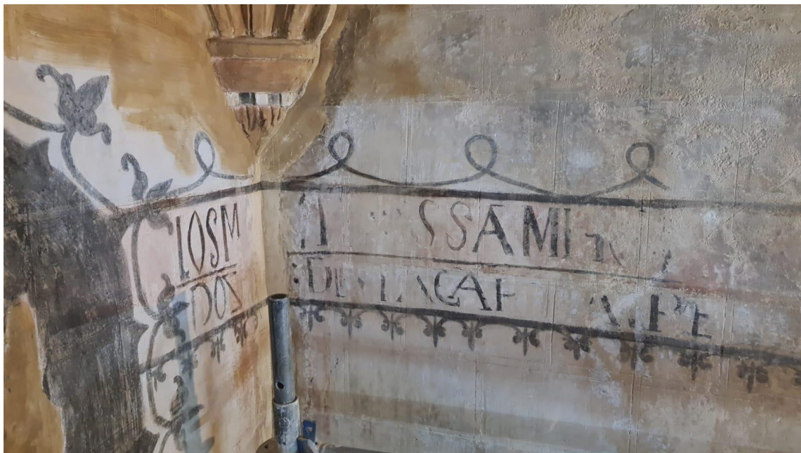
Fig. 24. Detalle de la intervención (en proceso de secado).
