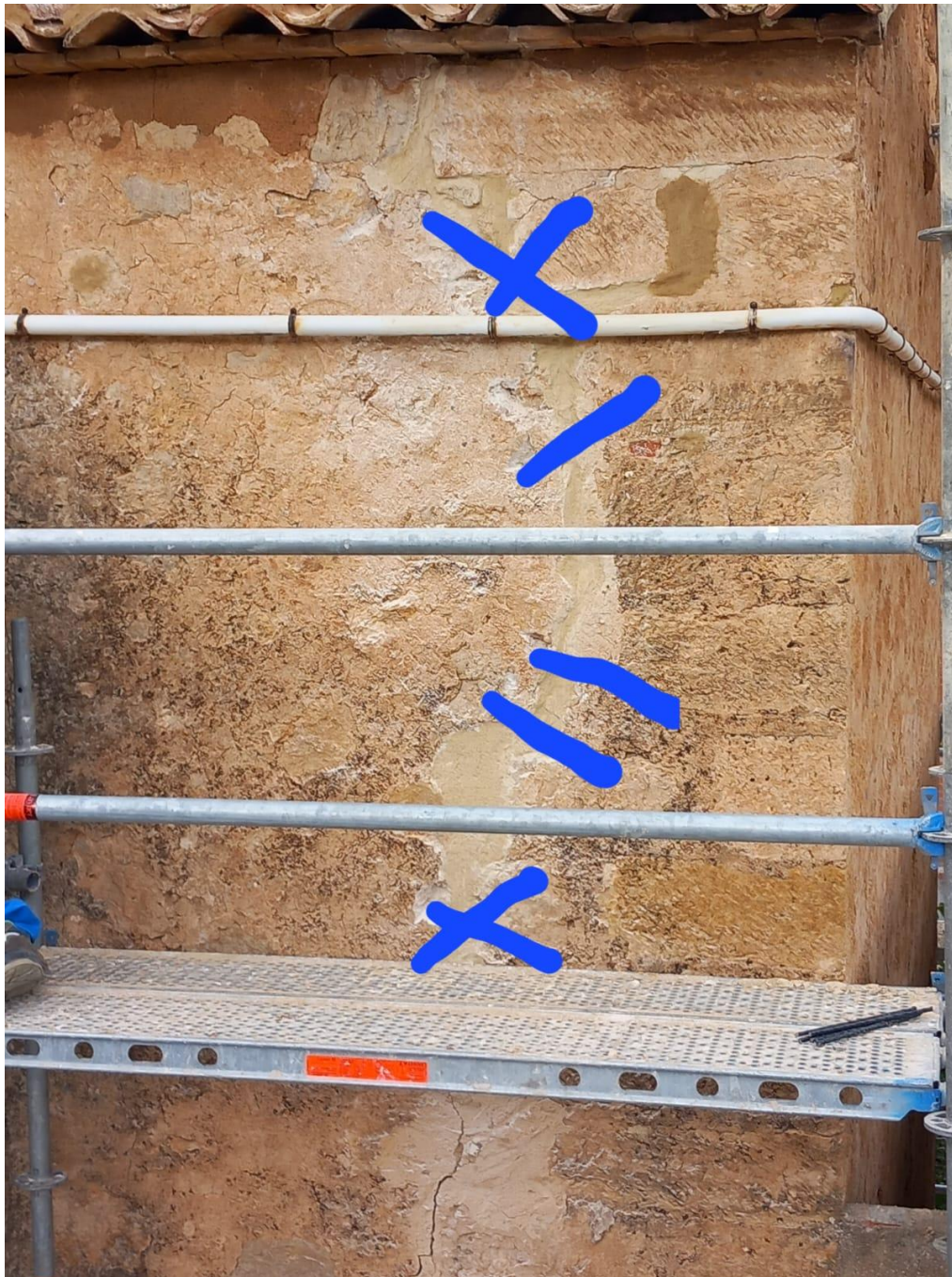
Fig. 3.3.13_ Señalización de los puntos de cosido del trazado superior de la grieta mediante varillas
