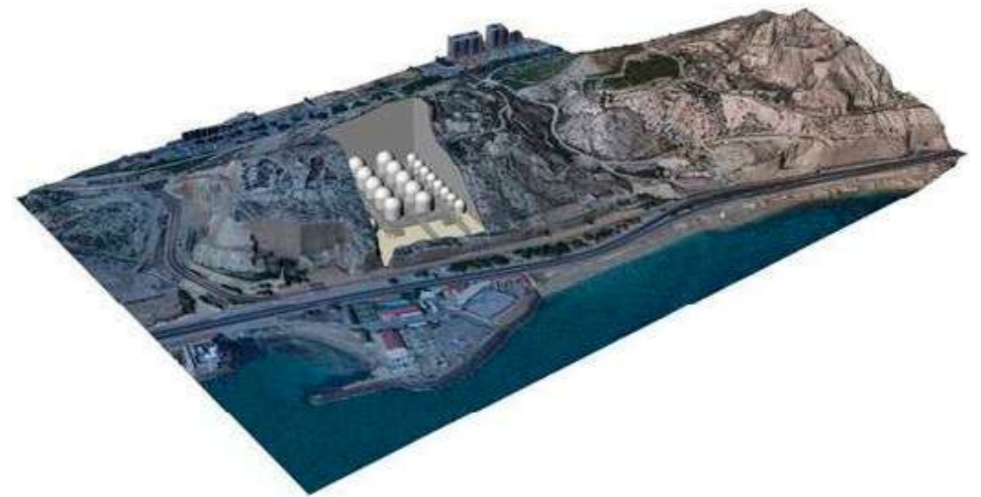
n. 13. Vista aérea de situación de los depósitos la Británica en relación a otras infraestructuras subterráneas Imagen procedente de: http://www.150ferrocarrilalicante.gva.es/historia.aspx?ID=65tema=6
