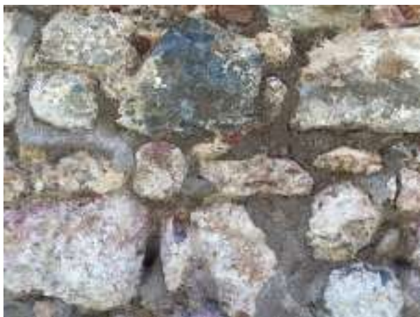
Vista de la fàbrica de maçoneria que constitueix el mur amb restes visibles d'emblanquinat anteriors a l'arrebossat
