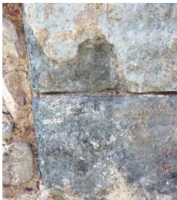
Detall de la pedra de l'arc dovellat amb restes de la pintura blava que el cobria, anterior a l'arrebossat
