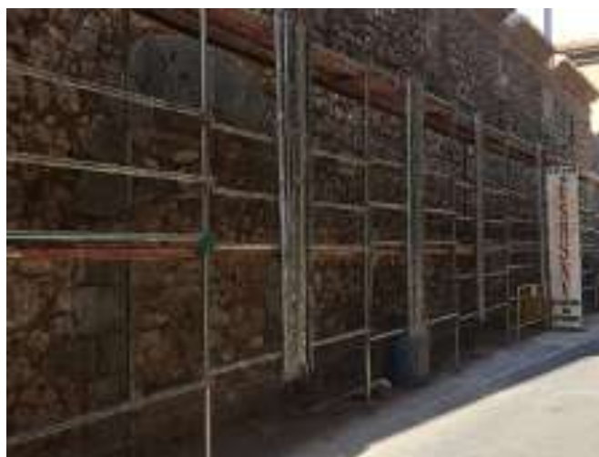
Vista general de l'estat de les obres d'intervenció en el mur nord de l'església
