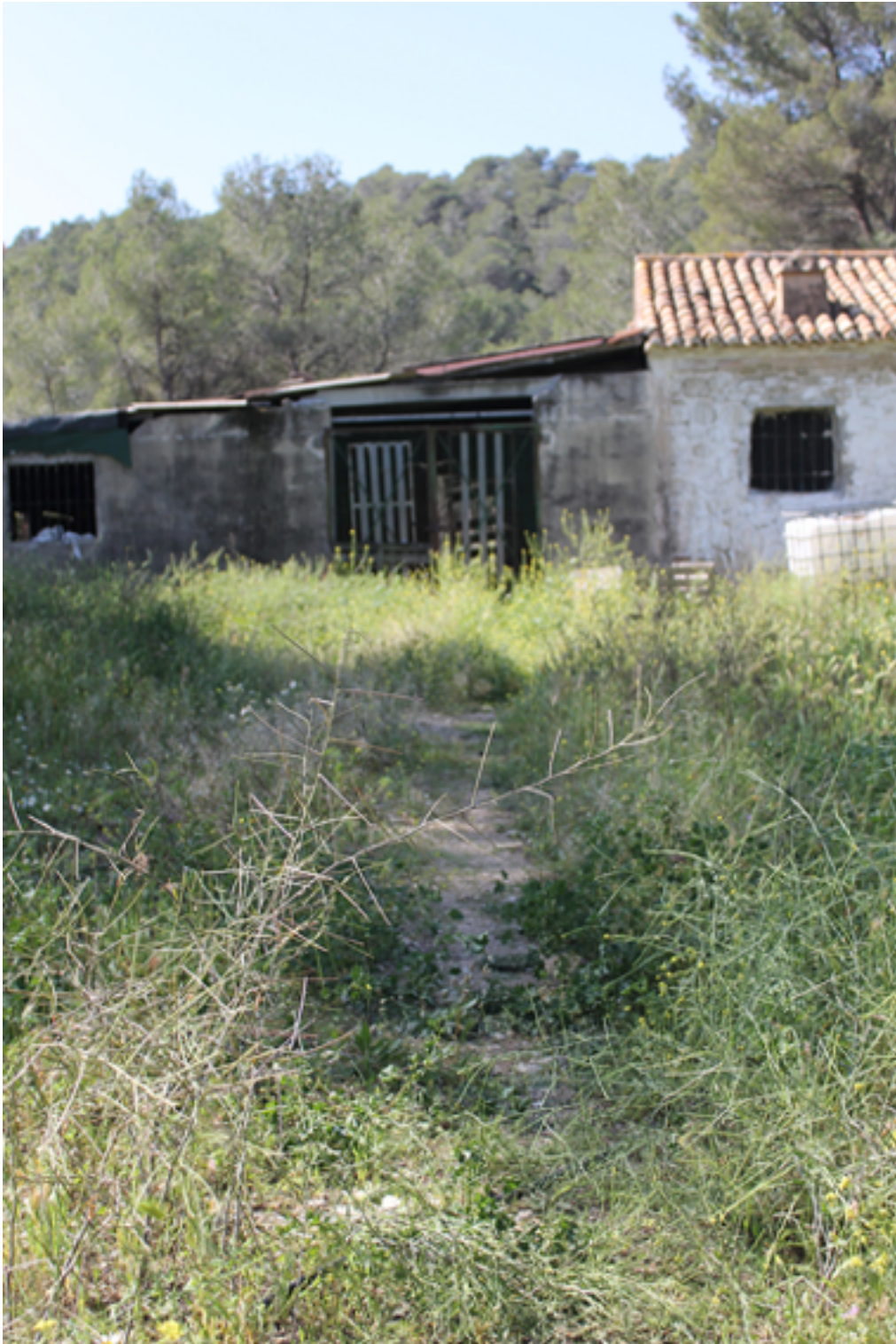
Antigues cavallerisses a la línia Carcaixent-Dénia.
