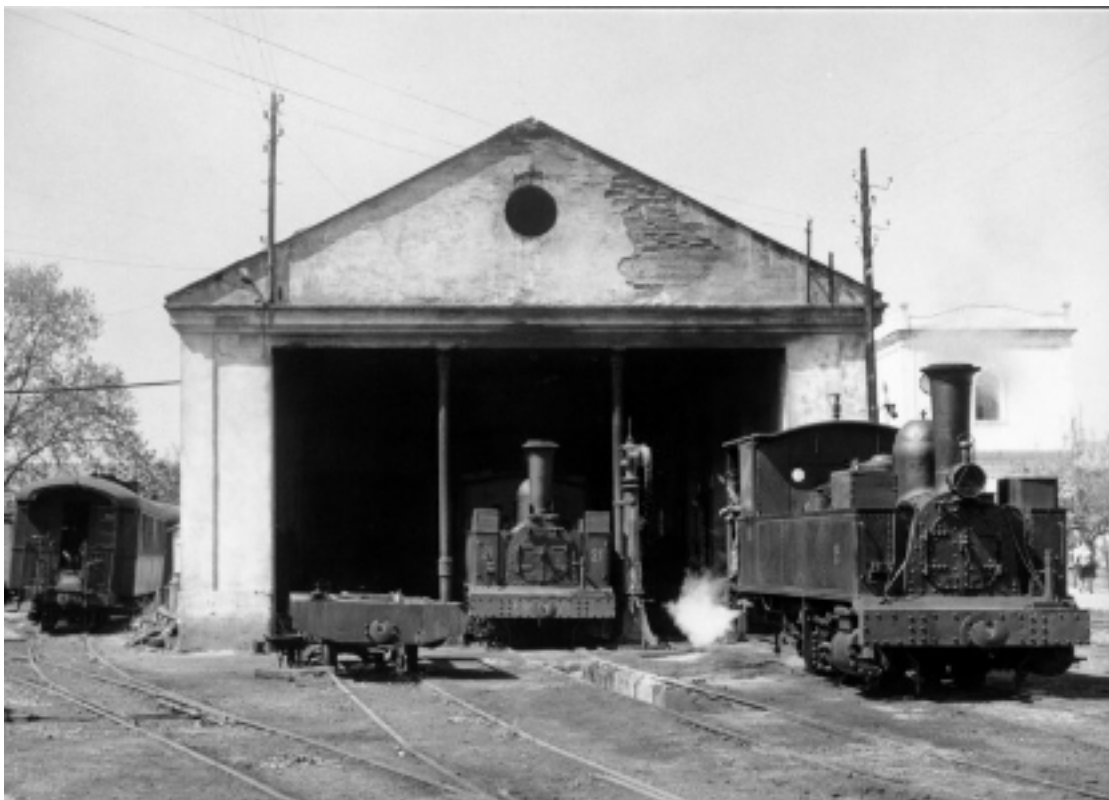
Dipòsit de locomotores de Carcaixent, a la línia Carcaixent-Dénia.
