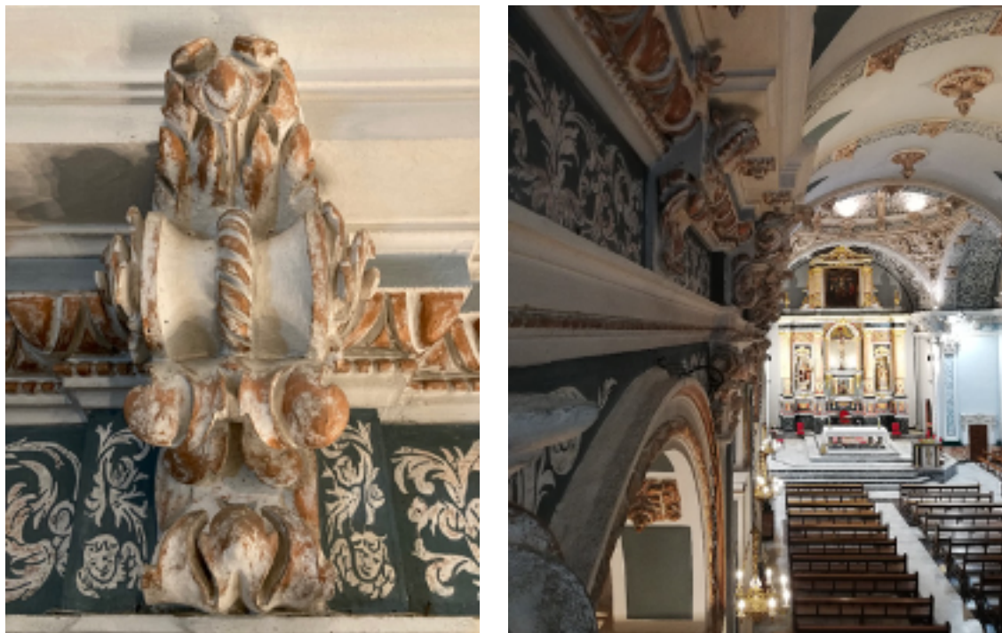
Detall d'un dels estucs i esgrafiats de l'església situat a la nau principal
