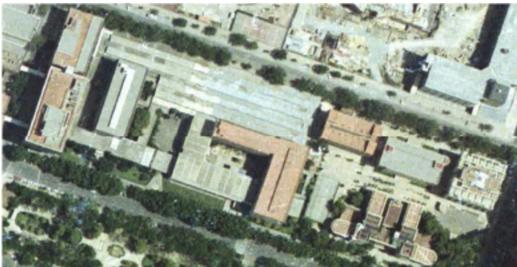
Vista aérea mostrando la adición en forma de L sobre-elevada
