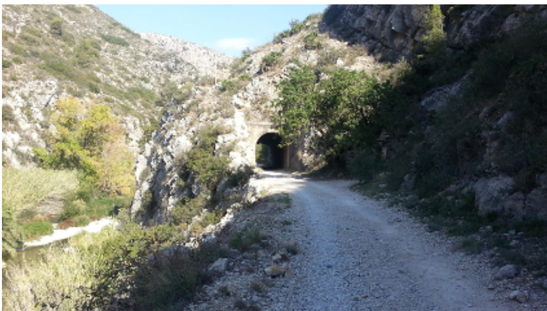
Túnel del tren Alcoi-Gandia.
