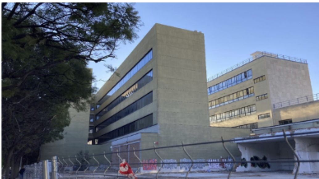
Vistas del Aulario recayente a Menéndez Pelayo Arquitecto: Juan García Carrillo.2009-2010.
