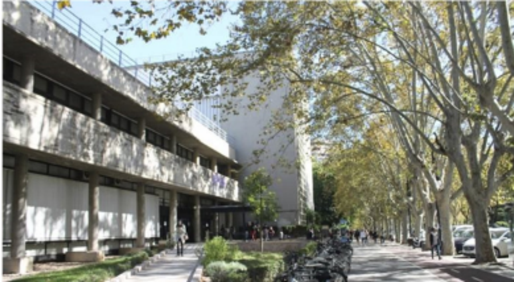
Vista del cos sobrelevat donant a l'avinguda Blasco Ibáñez. Arquitecte: Miguel Colomina Barberá, 1986
